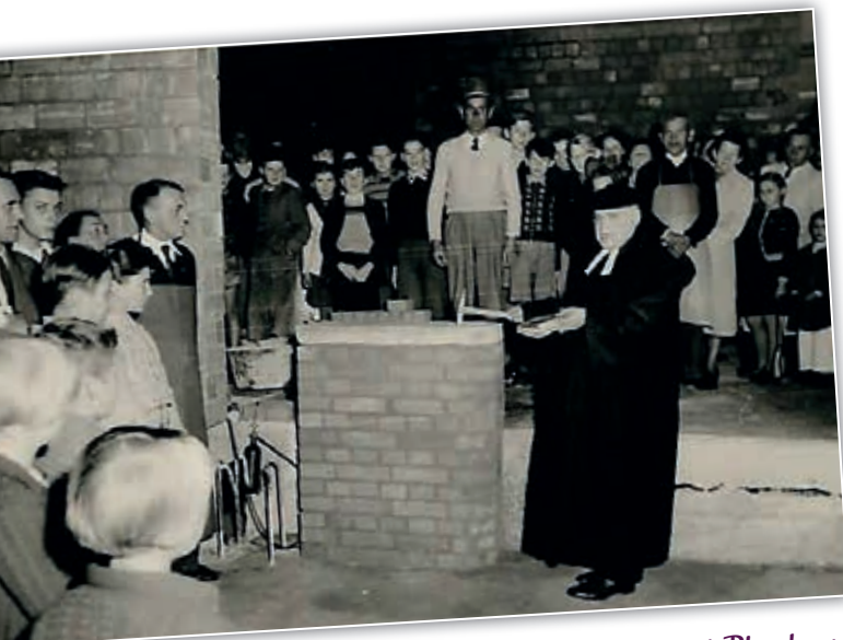
Grundsteinlegung für die Friedenskirche mit Pfarrhaus und Gemeindesaal am 23.10.1954
