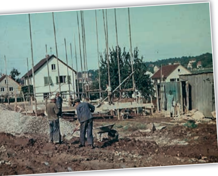
Erste Bauabschnitte auf dem Weg in die Höhe
